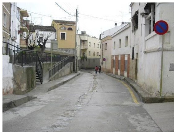
Imatge 8: Carrer Riera amb una vorera estreta mobiliari urbà obstaculitzant.
