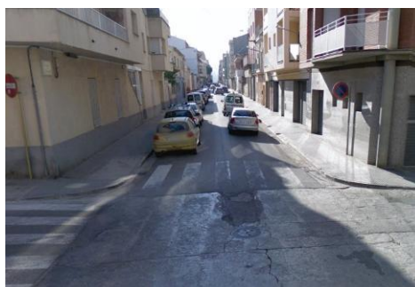
Imatge 9: Pas de vianants desgastat i sense gual.
