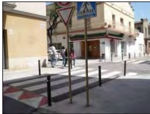
Fig. 23. Pas de vianants a nivell de la vorera al carrer Colón. Font: elaboració pròpia
